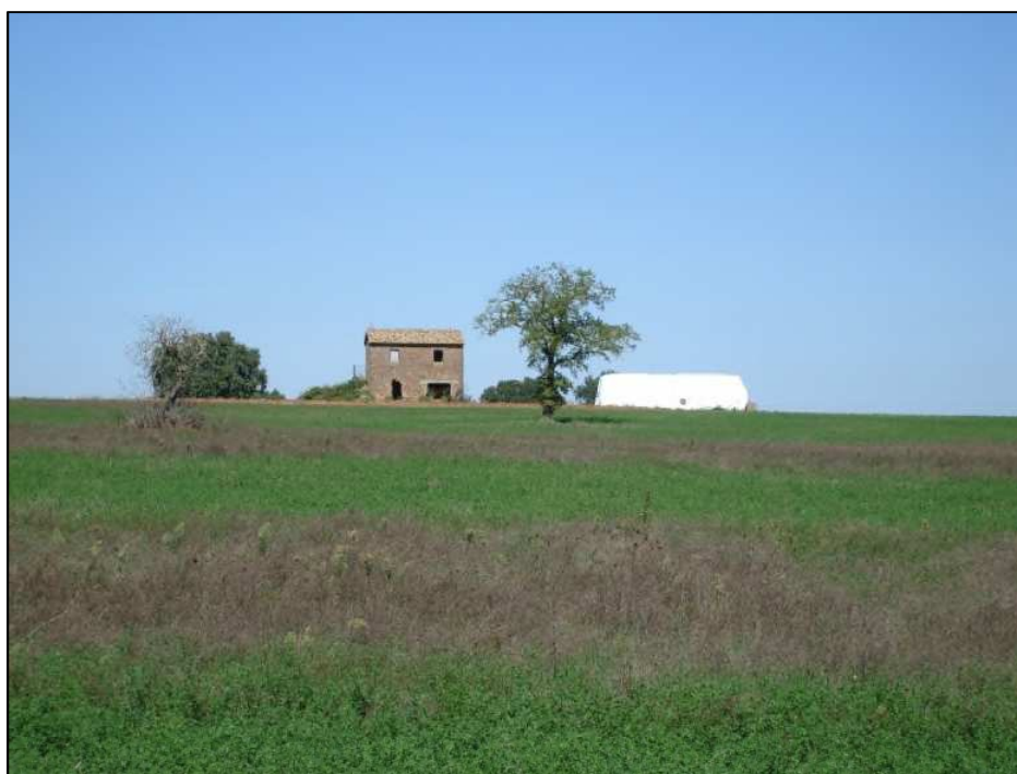
Figura 4.1 Casale storico in stato di abbandono (località Caprigliano).
